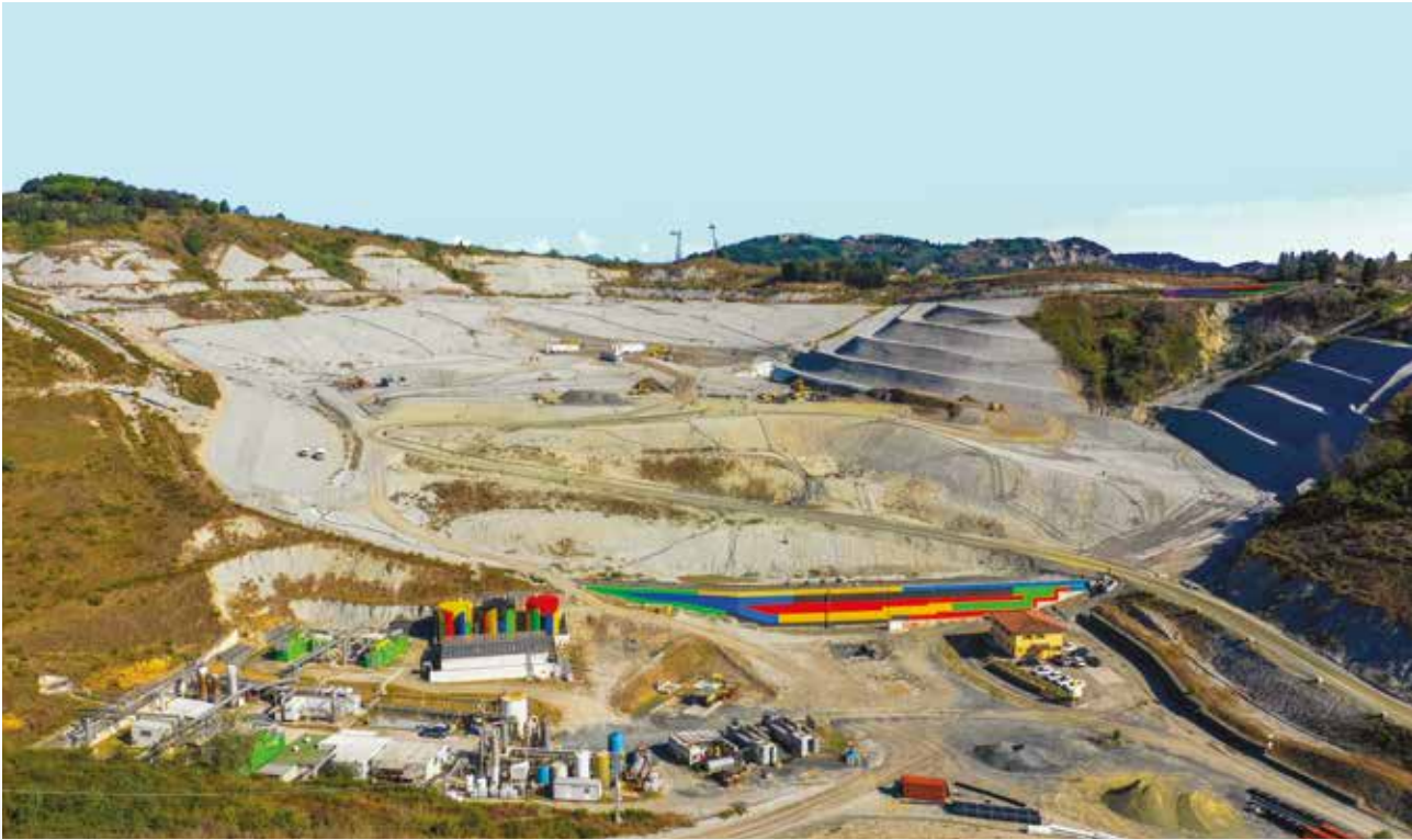
Vista di insieme impianto di smaltimento
