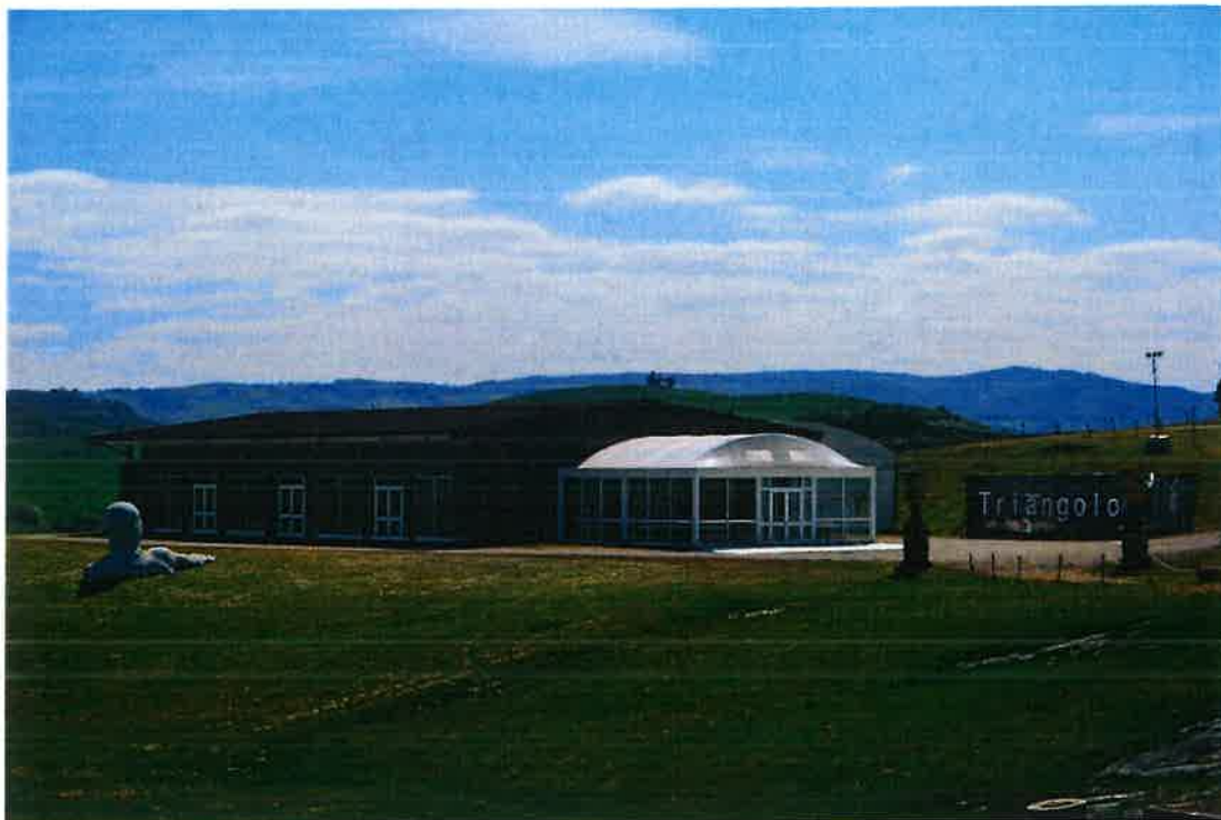
Figura 4: Vista panoramica della struttura a servizio dell'impianto per le visite guidate
