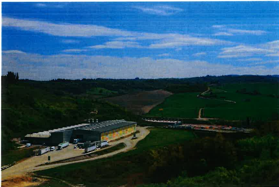
Figura 9: Panoramica impianto TMB
