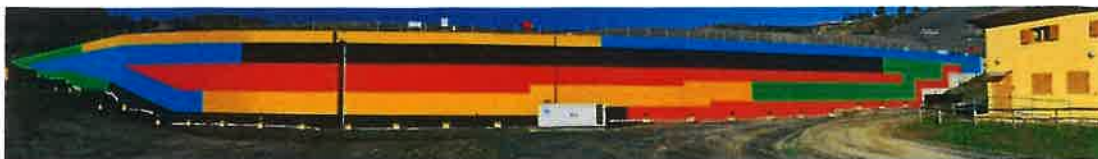
Figura 5: Vista della diga di sbarramento dell'ampliamento
