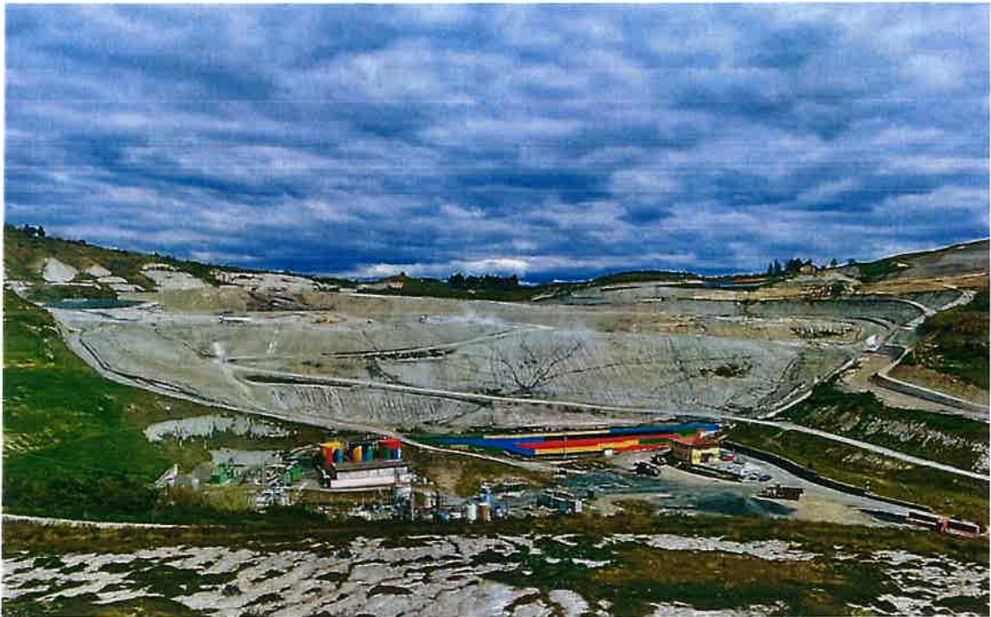
Figura 7: Vista panoramica dell'ampliamento
