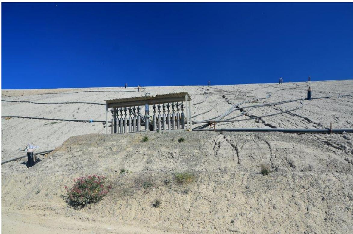
*Figura 5: Vista di un collettore di adduzione del biogas*
