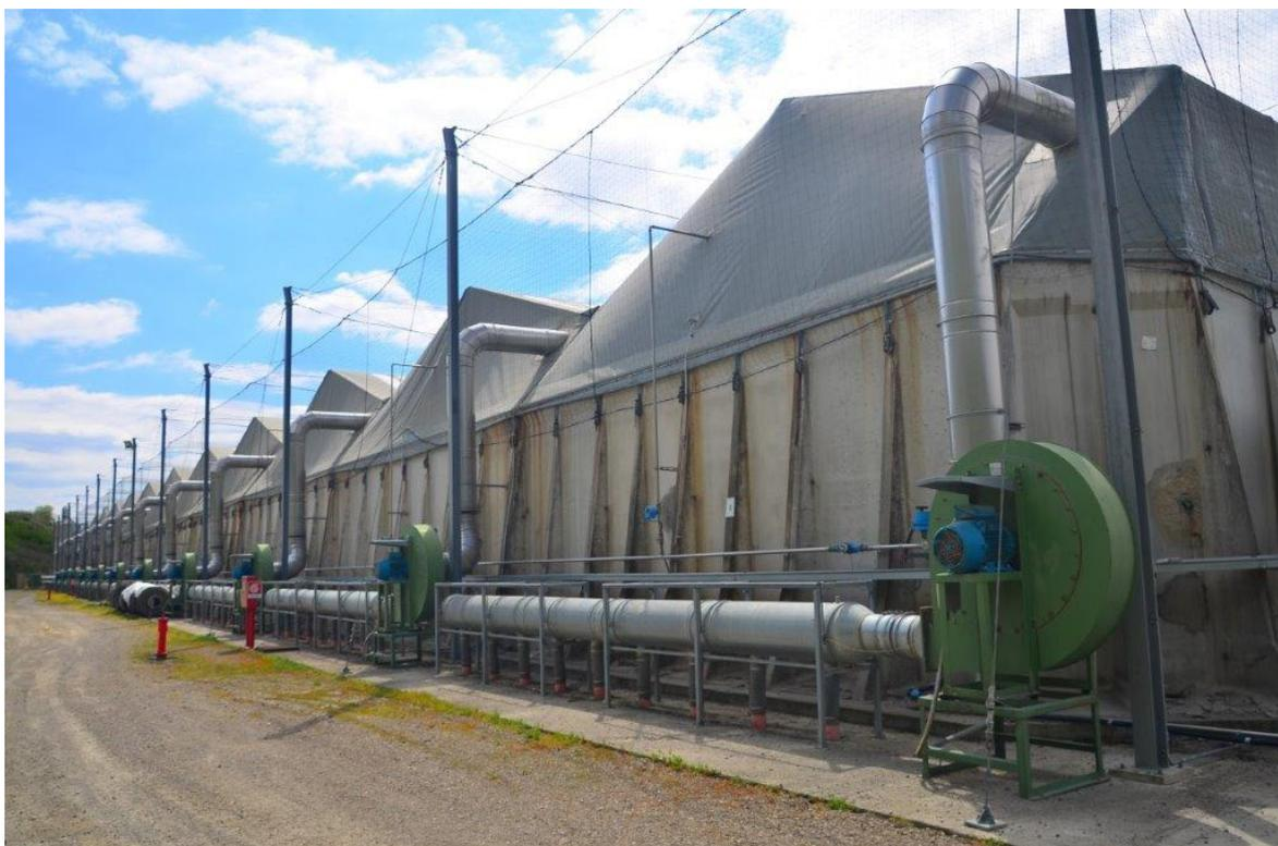
**Figura 6: Vista della sezione di biostabilizzazione**
