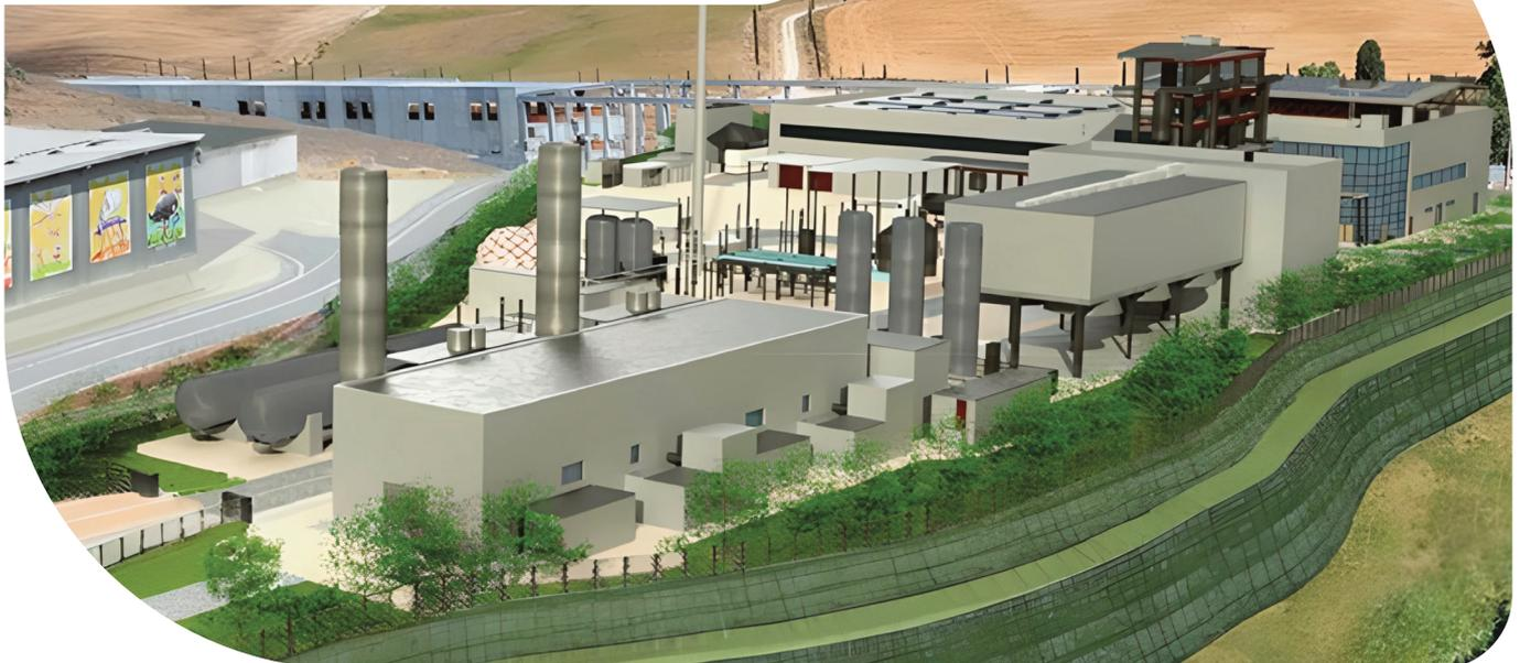
L'impianto si basa sulla tecnologia Isotherm "Flameless Pressurized Oxy-Combustion" (FPO), un particolare processo di ossicombustione mediante una tecnologia di combustione senza fiamma, molto diverso dalla combustione tradizionale. La sua collocazione nel polo impiantistico di Belvedere consente di prevedere importanti sinergie volte alla migliore applicazione possibile dei principi della circolarità, in quanto:
