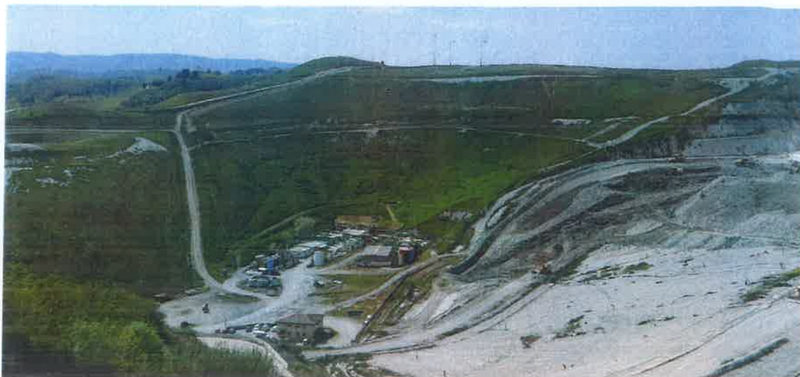
Figura 5: Vista panoramica dell'ampliamento
