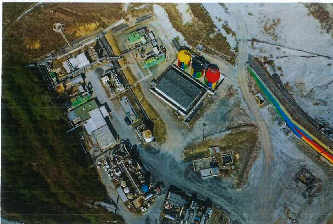
Figura 6: Vista dell'area tecnologica dall'alto
