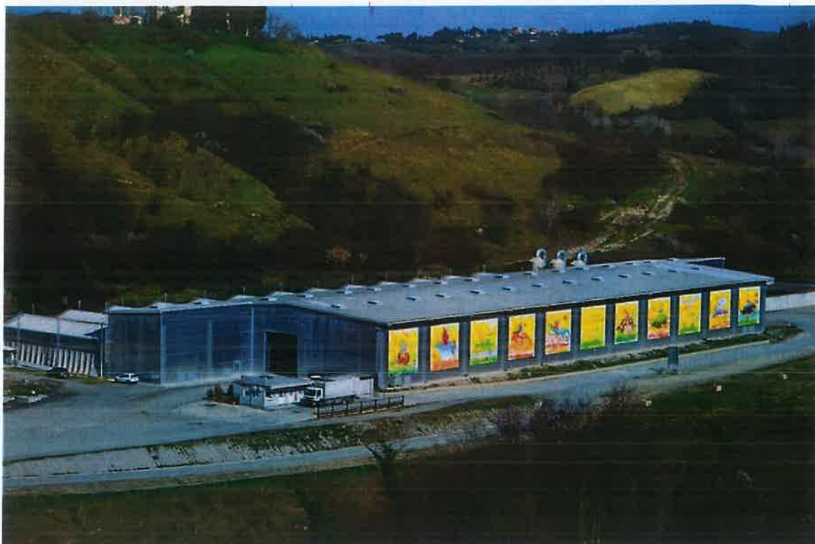
Figura 7: Vista panoramica dell'impianto TMB
