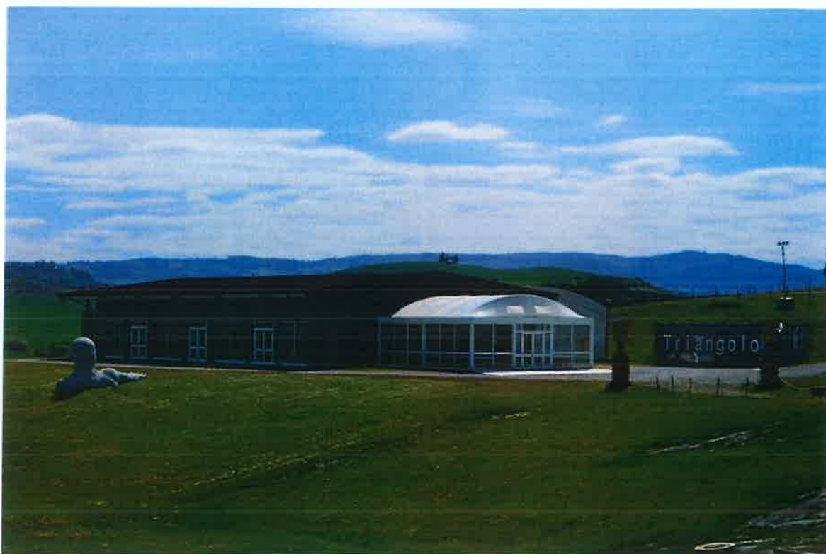
Figura 1: Vista panoramica della struttura a servizio dell'impianto
