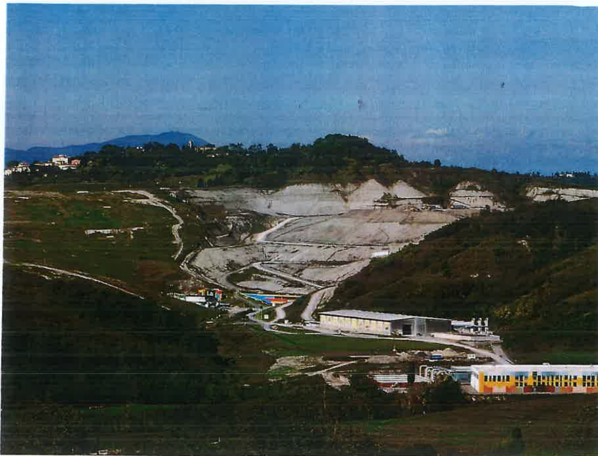
Figura 4: Vista panoramica del sito
