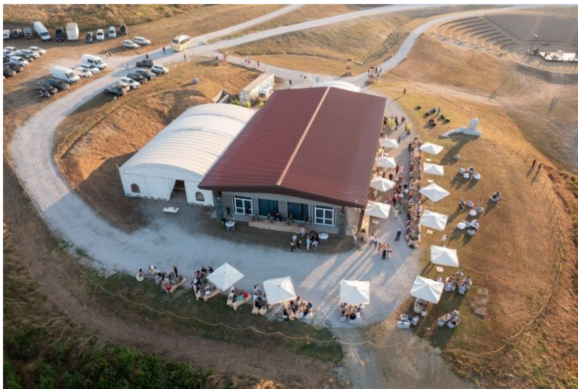
Figura 1: Vista panoramica della struttura a servizio dell'impianto
