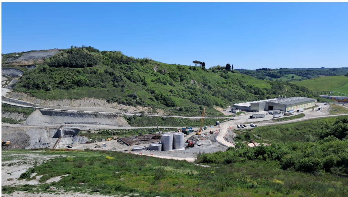
Figura 6: Vista panoramica della realizzazione dei nuovi serbati di stoccaggio del percolato
