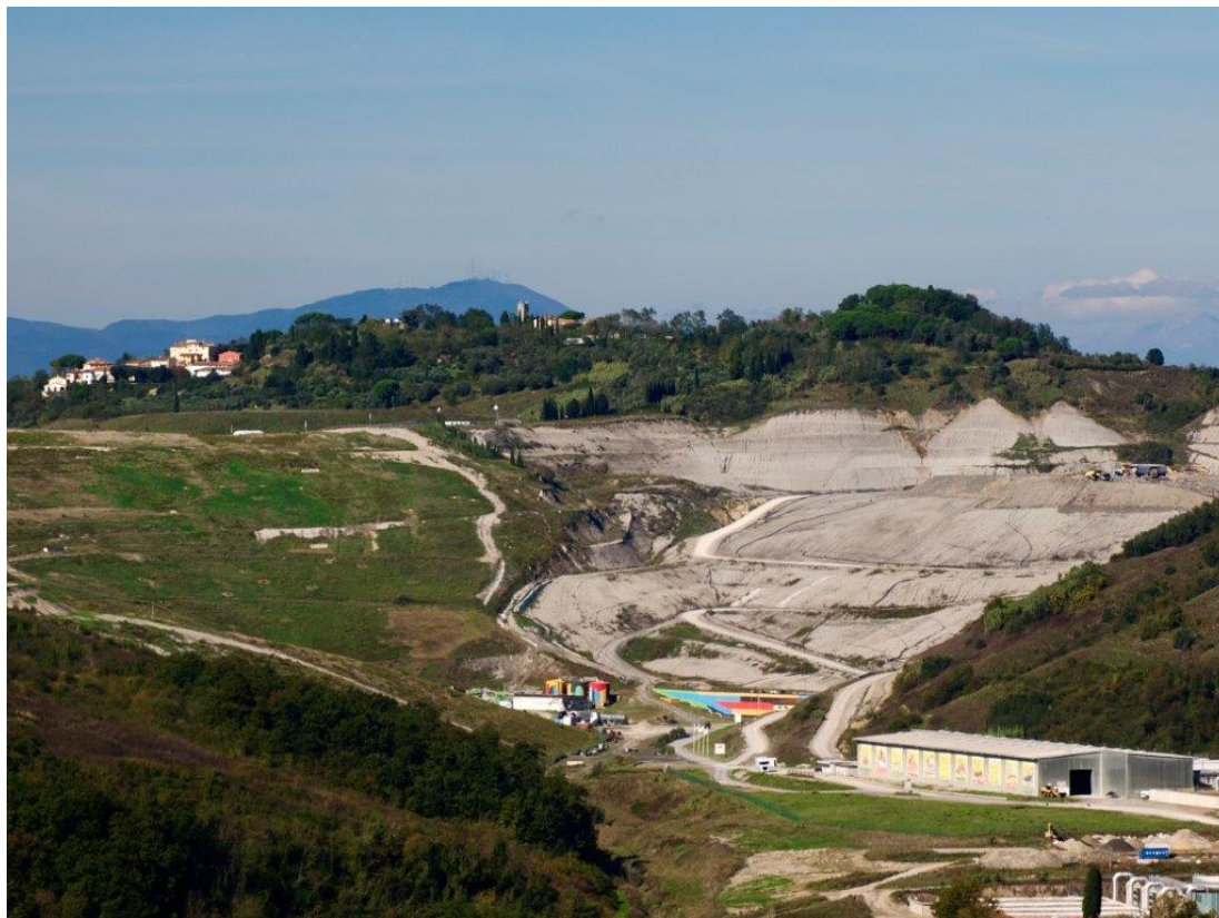
Figura 10: Vista panoramica del sito
